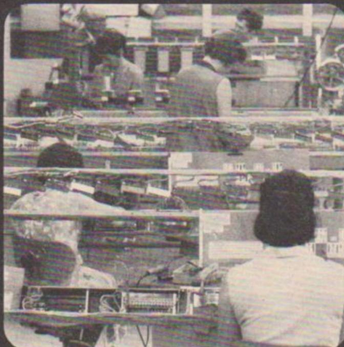
Eins zum anderen. Mechanische Bauteile, elektrische Bauteile, Gestellrahmen-Drahtkabel, Wählerrahmen. Das Ganze fügt sich zusammen. Gestellrahmen entstehen.
