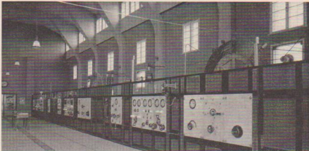
Drei Telefunken-Röhrensender für Telefonie und Rundfunk im Senderhaus 3
