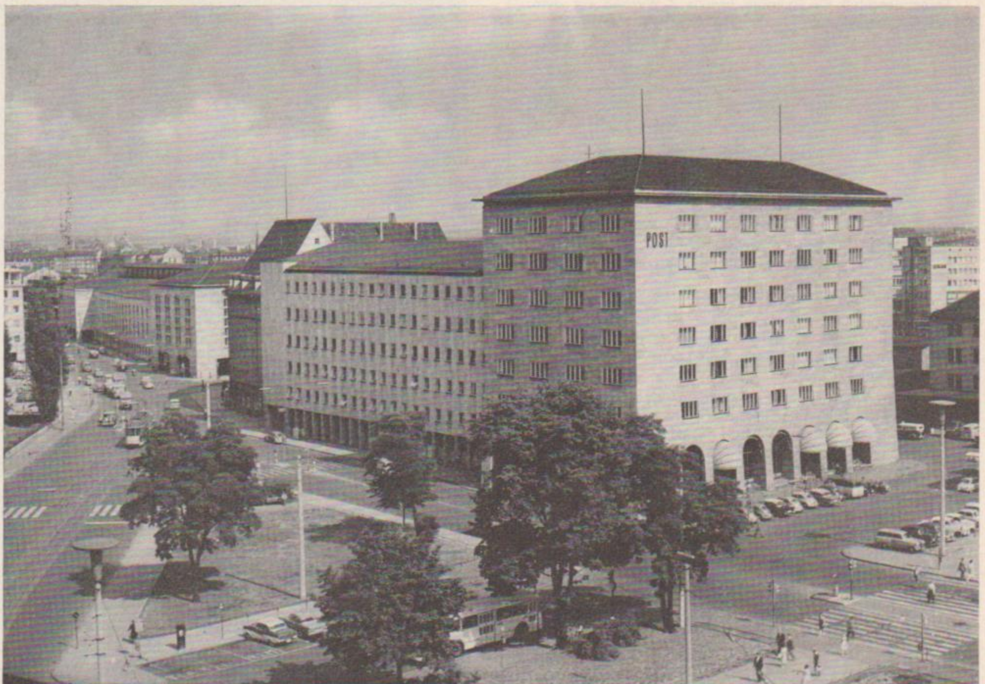
Postzentrum in Nürnberg
