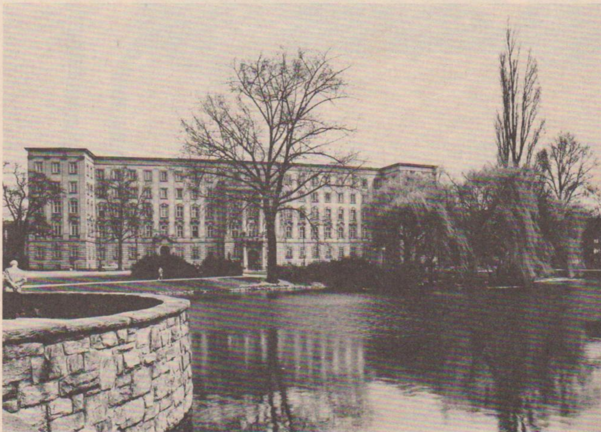
Gebäude der Oberpostdirektion Frankfurt am Main an der Friedrich-Ebert-Anlage
