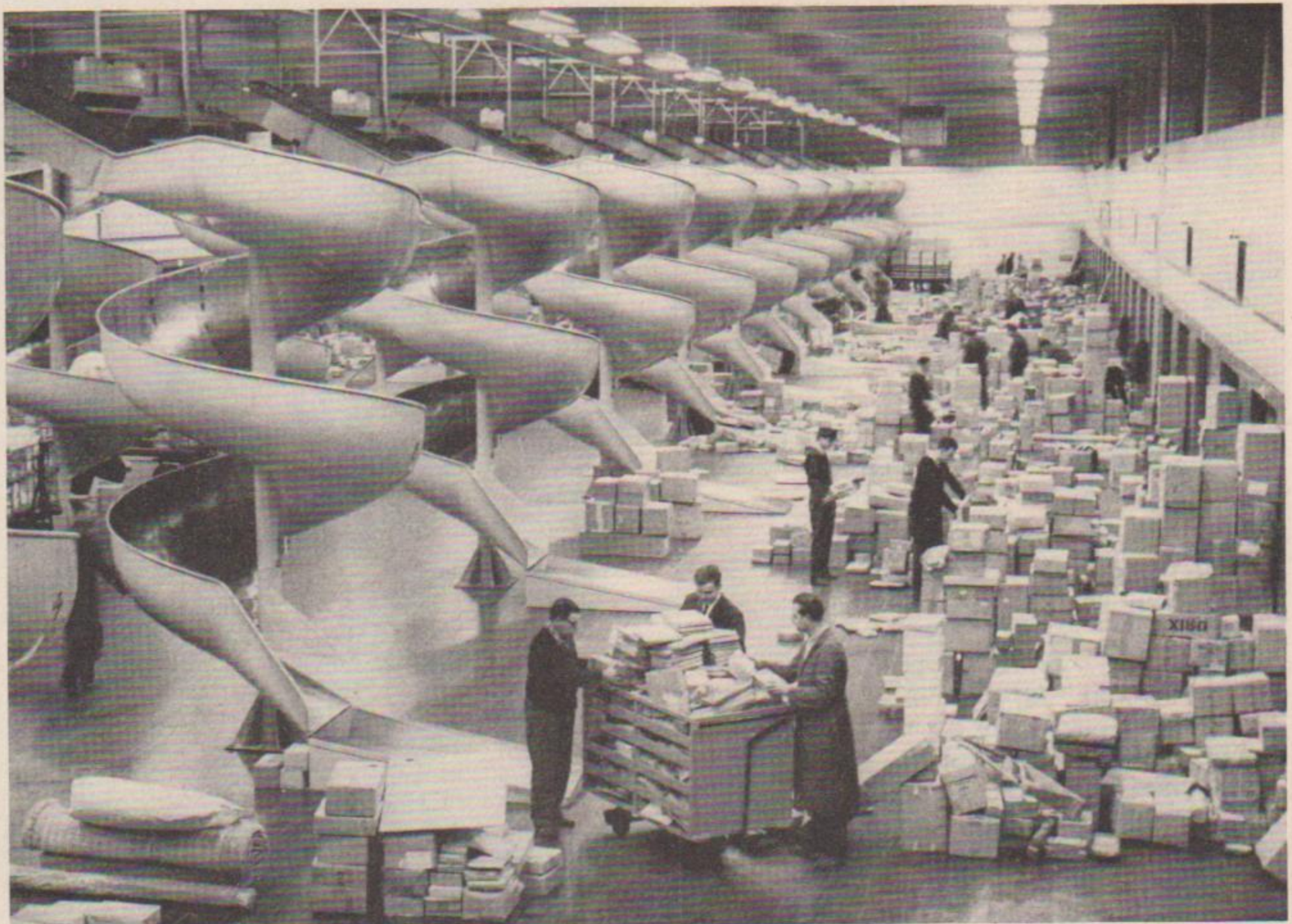
Zielgesteuerte Paketverteilanlage beim PA Braunschweig 1 (Vorbereitung zur Pkt-Zust.)
